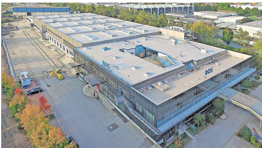
Der Um- und Neubau der Firma Ros am ehemaligen Coburger Güterbahnhof geht planmäßig voran. Das Werk soll Anfang 2018 vom jetzigen Standort in der Bamberger Straße in die neuen Betriebsgebäude umziehen. Foto: Ros
